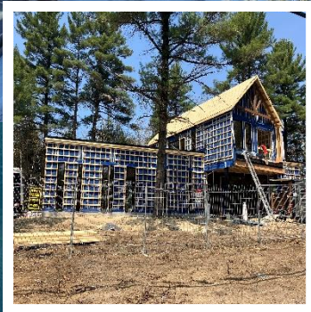
Le bâtiment prend forme! La charpente est presque complétée en mai 2023.
